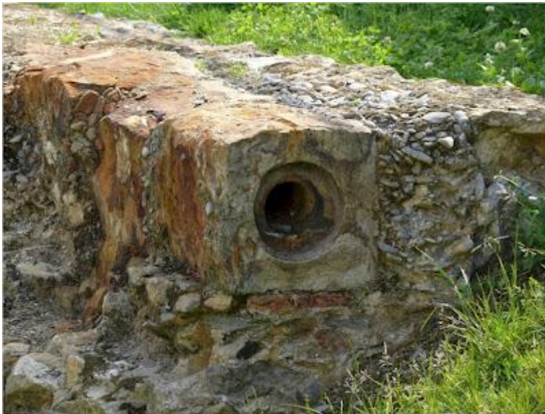
Restos de tubería romana Castrourdiales
