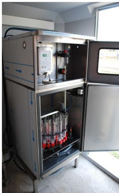
Material utilizado por A.M.B en una red de control de colectores.
