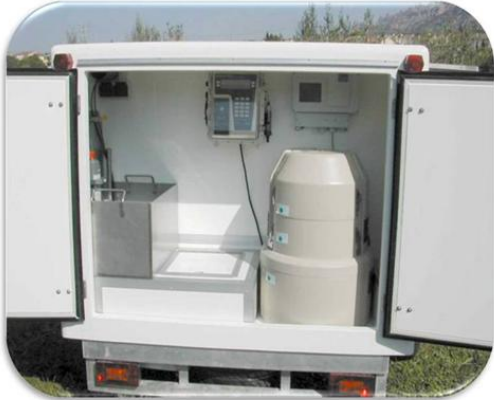
Material utilizado por la A.M.B del Área Metropolitana de Barcelona
