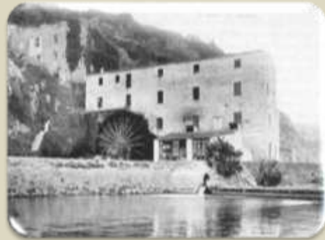
Rueda hidráulica empleada en dar movimiento a la fábrica de curtidos Anglada y Cía. En Esparraguera, Barcelona
