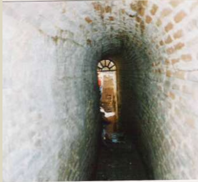
Galería de conducción del viaje de agua a su llegada al arca de Amanuel
