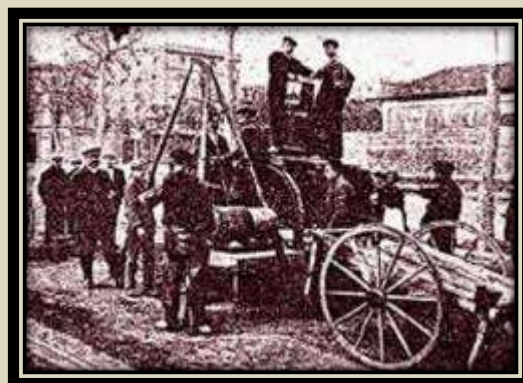
Carro hermético de limpieza de alcantarillas. Madrid 1911
