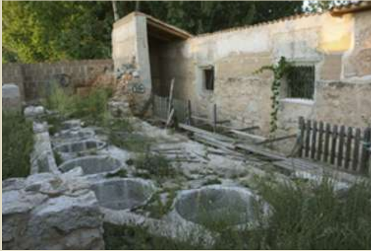
Lavadero de lana del Jiloca
