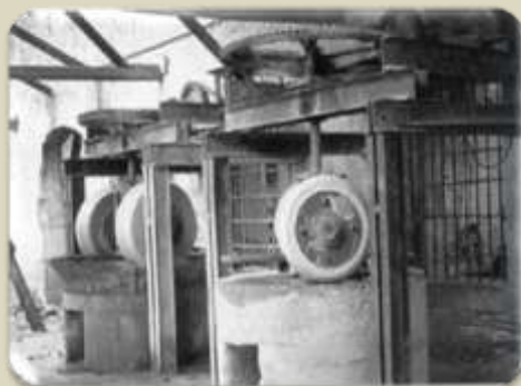
Molinos de tipo almazara empleados en la Real Fábrica de Cristales de San Ildefonso. Segovia
