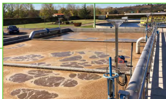
Ampliación EDAR Zamora. Proceso biológico con eliminación de nitrógeno y fósforo
