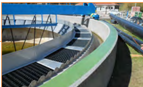
Fabricación y montaje de módulos lamelares en PVC
