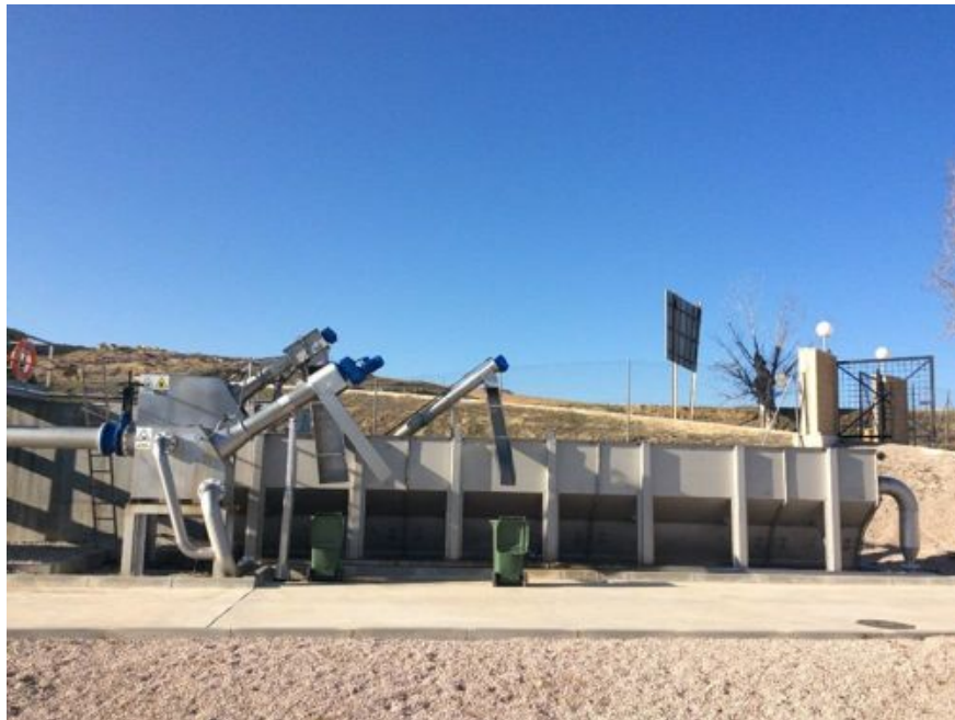
Imagen 2: Tamizado y desarenado-desengrasado EDAR de estudio 1, “fangos activos” en equipo compacto. Imagen propia.
