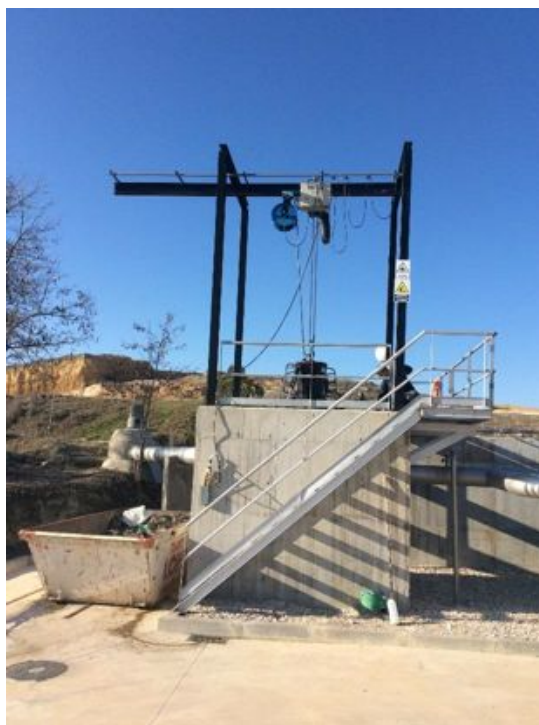
Imagen 1: Pozo de gruesos EDAR de estudio 1 “fangos activos”, incluida vista superior durante la entrada de un vertido lácteo en dicha EDAR. Fuente: Imágenes propias.
