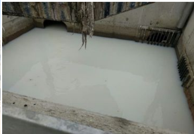
Imagen 1: Pozo de gruesos EDAR de estudio 1 “fangos activos”, incluida vista superior durante la entrada de un vertido lácteo en dicha EDAR. Fuente: Imágenes propias.
