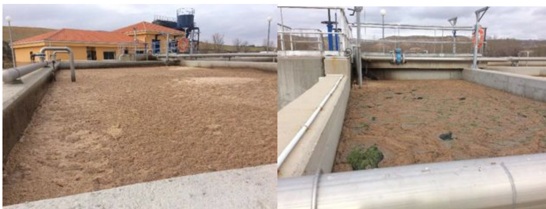
Imagen 11: “bulking filamentoso” existente en los reactores óxico y anóxico de la EDAR 1 de estudio “fangos activos”, debido a los vertidos industriales. Fuente: Imágenes propias.
