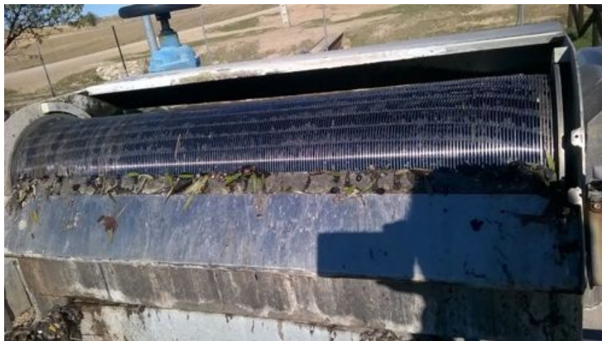
Imagen 8: Hojas de olivo en el tamiz de la EDAR de estudio 2, afectada por vertidos de dos Almazaras. Imagen propia.
