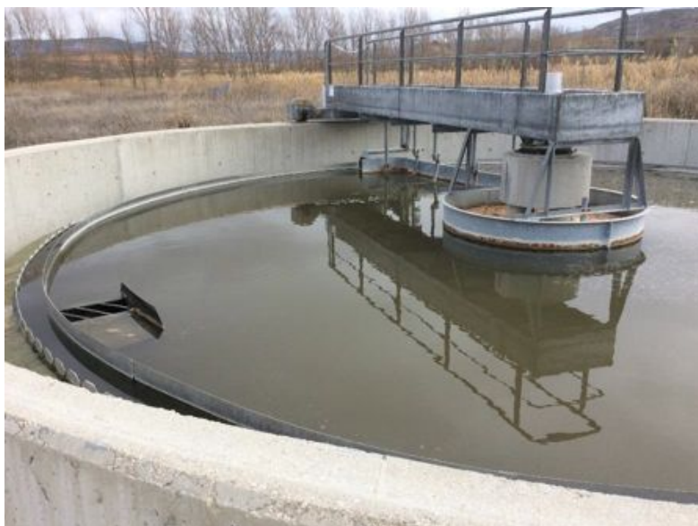
Imagen 4: Línea 1 de decantación secundaria de la EDAR de estudio 1, “fangos activos” en decantadores circulares. Imagen propia.
