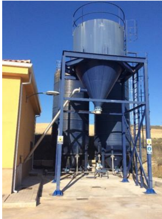
Imagen 6: Espesadores circulares y tolva de fangos de la EDAR de estudio 1, “fangos activos”. Imagen propia.
