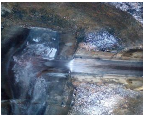
Imagen 13: Vertido en la arqueta de la industria SUEROS conectada con la EDAR 1 de estudio “fangos activos”, durante una inspección por parte de la empresa explotadora de la EDAR urbana. Fuente: Empresa explotadora.
