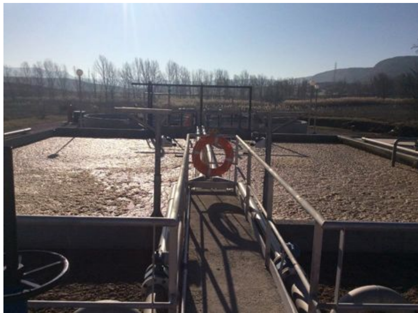
Imagen 3: Tratamiento biológico EDAR de estudio 1, “fangos activos” en reactores anaerobios y aerobios. Imagen propia.
