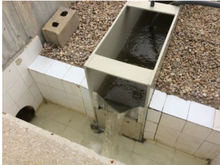
Imagen 5: Arqueta de salida y toma de muestras de la EDAR de estudio 1, “fangos activos”. Imagen propia.
