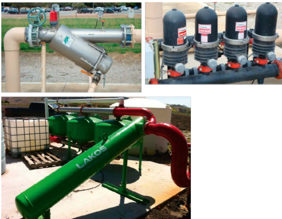
Ilustración 29. Arriba, de izquierda a derecha: Filtro de malla y de discos. Abajo: sistema combinado con filtro centrífugo (primer plano) y filtros de arena (segundo plano). Fuente: [2]
