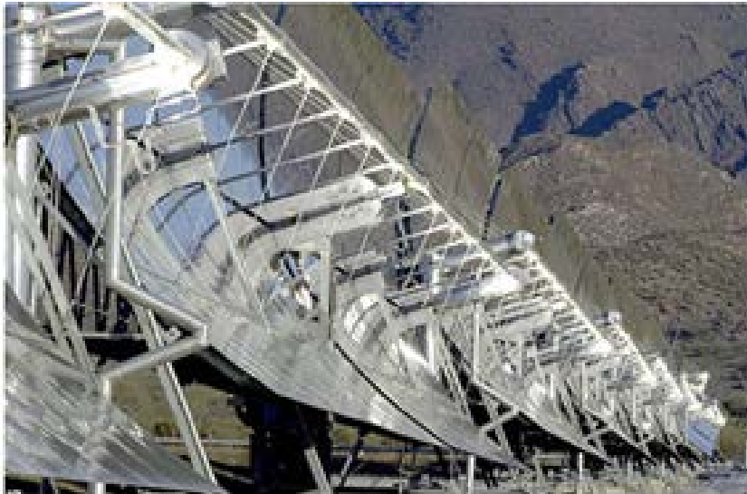
Ilustración 50. Seguimiento con eje horizontal E-O en concentradores cilindro-parabólicos de energía solar térmica de alta temperatura. Fuente: Plataforma solar de Almería
