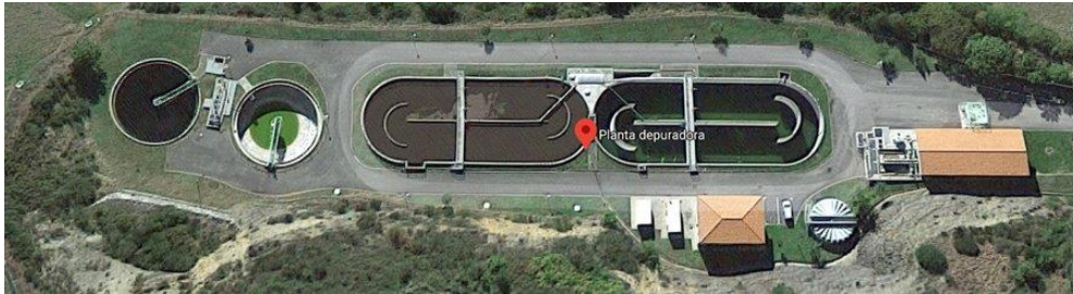
Figura 1: Reactor biológico de la EDAR de Tineo.
