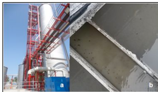
Figura 1. Instalaciones de la EDAR de Cobega Martorelles (Barcelona) y canal de salida del reactor biológico
