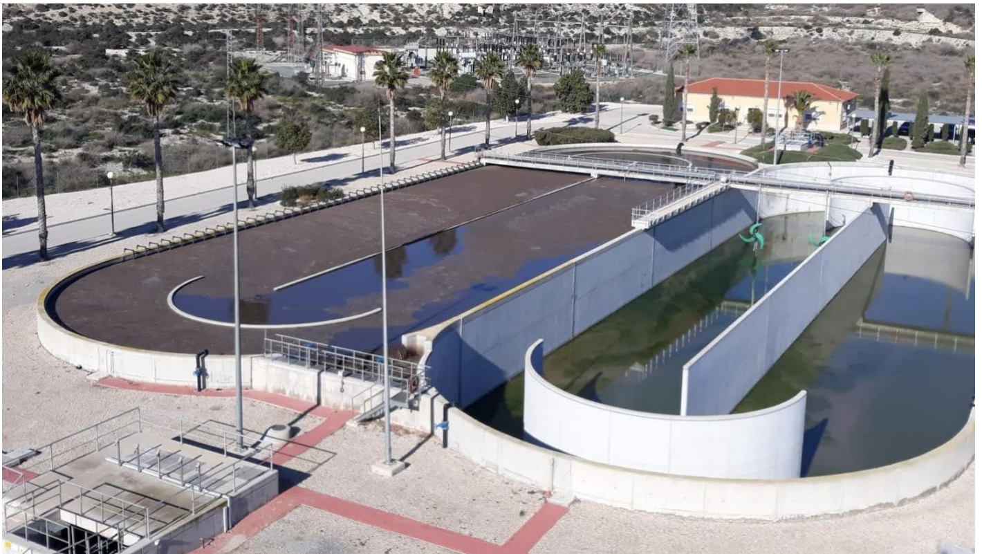
Figura 2. EDAR de Cieza (Murcia) – Reactor biológico
