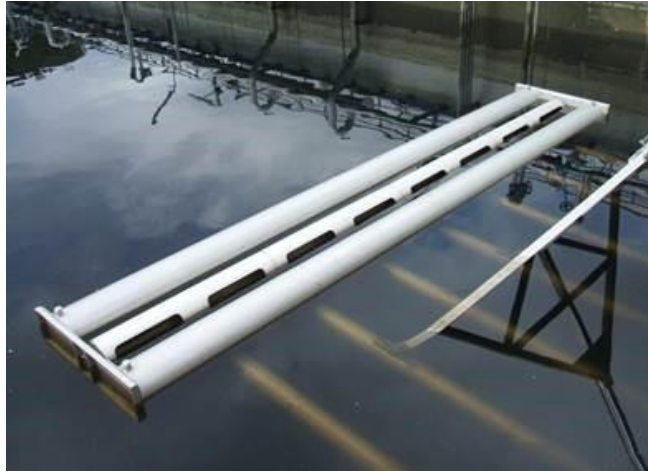
Figura 1. Decanter (flotador hidráulico) en condiciones normales de los reactores.
