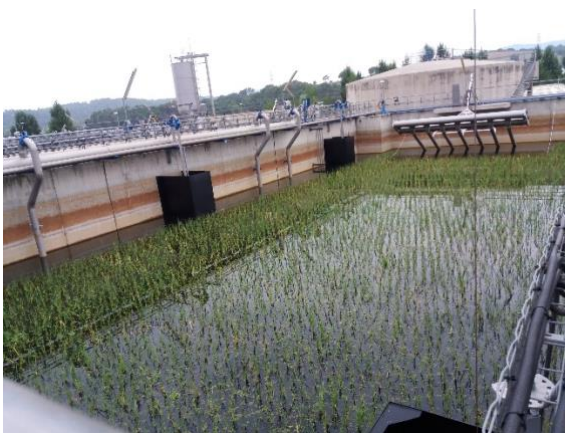
Figura 3. Instalación del HMF.
