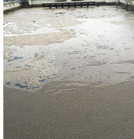
Figura 2. Capa de fangos en el reactor biológico generada por bulking.
