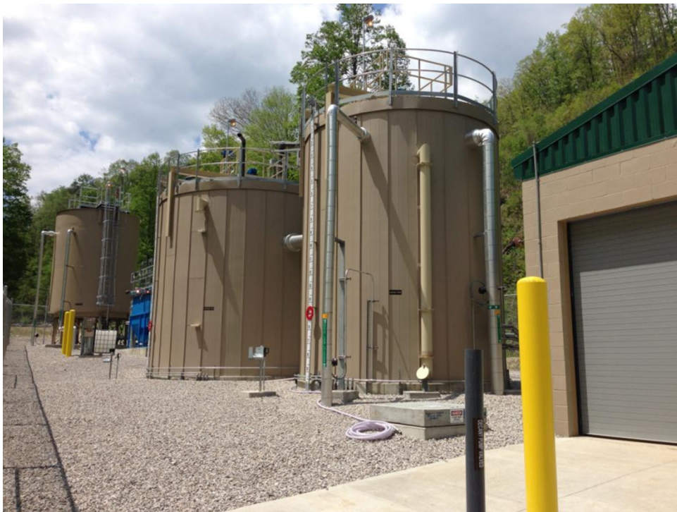
Figura 3. Imagen de la EDAR instalada en la Planta 1 en una de las minas de carbón de Estados Unidos. De derecha a izquierda, los principales equipos de la EDAR: 1ª MBBR de desnitrificación, 2ª etapa MBBR para reducción de selenio, Actiflo® (color azul) y espesador de fangos provenientes del Actiflo®
