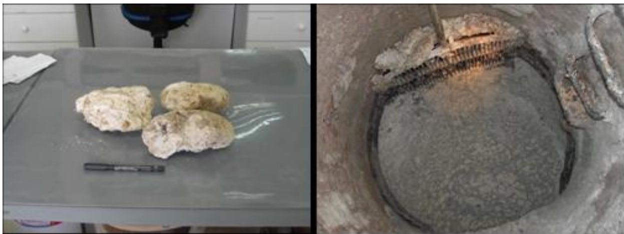
Figura 1 - izquierda, bolas de grasa; derecha, obstrucción de un colector con grasas (Fuente: EMACSA Córdoba)
