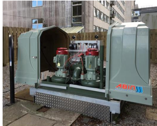
Figura 1. Estación de bombeo en superficie
