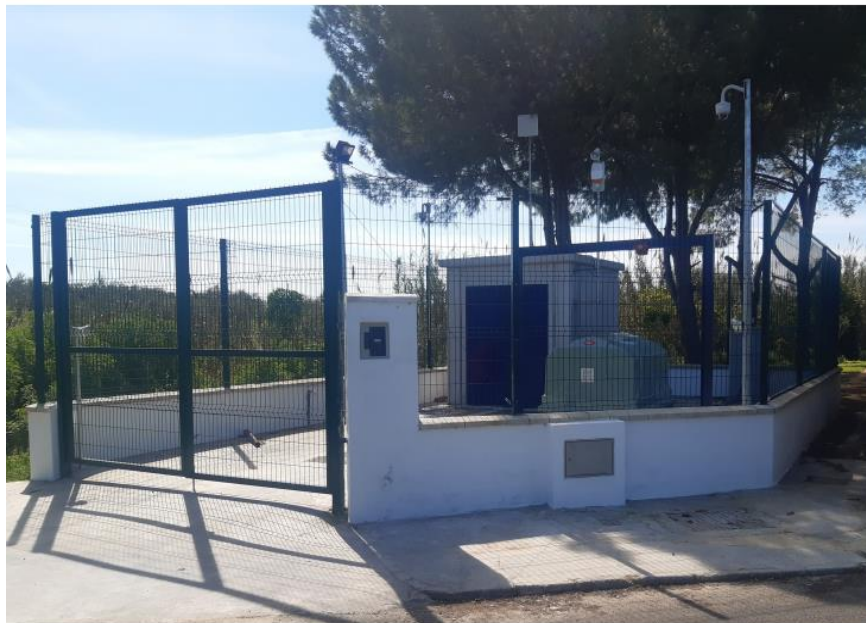
Figura 3. Estación de bombeo en superficie instalada en Bollullos de la Mitación, Sevilla
