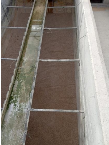
Figura-2 Detalle de los filtros de arena
