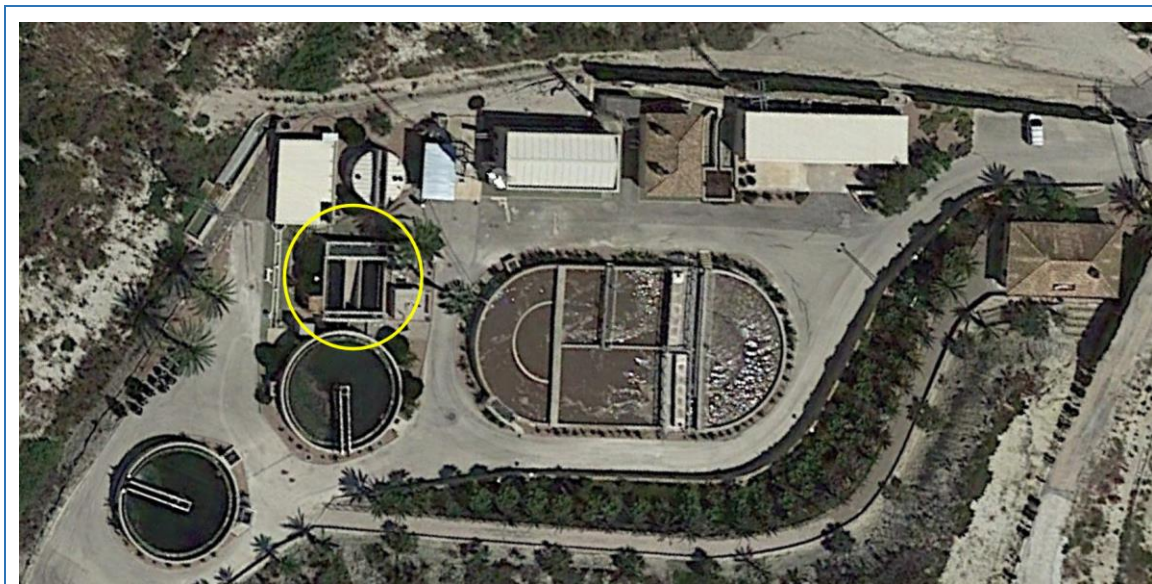
Figura-1 Ubicación de los filtros de arena en la EDAR de Abanilla
