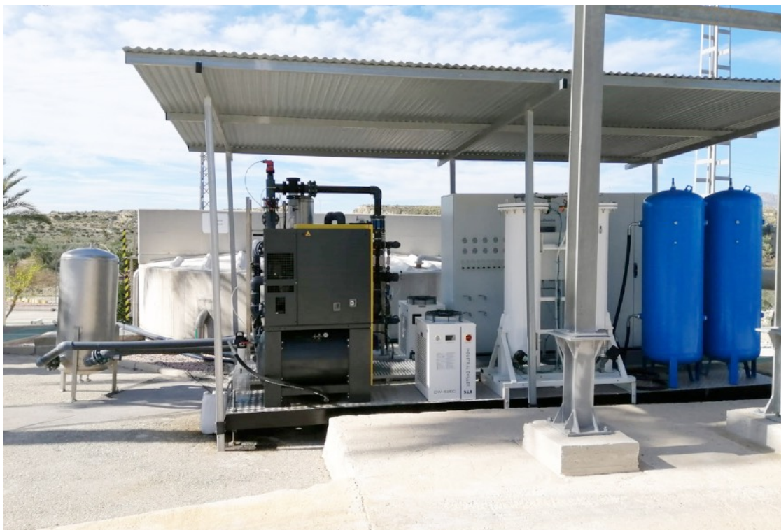
Foto-1: Vista general de la planta portátil de ozono instalada en EDAR Abanilla
