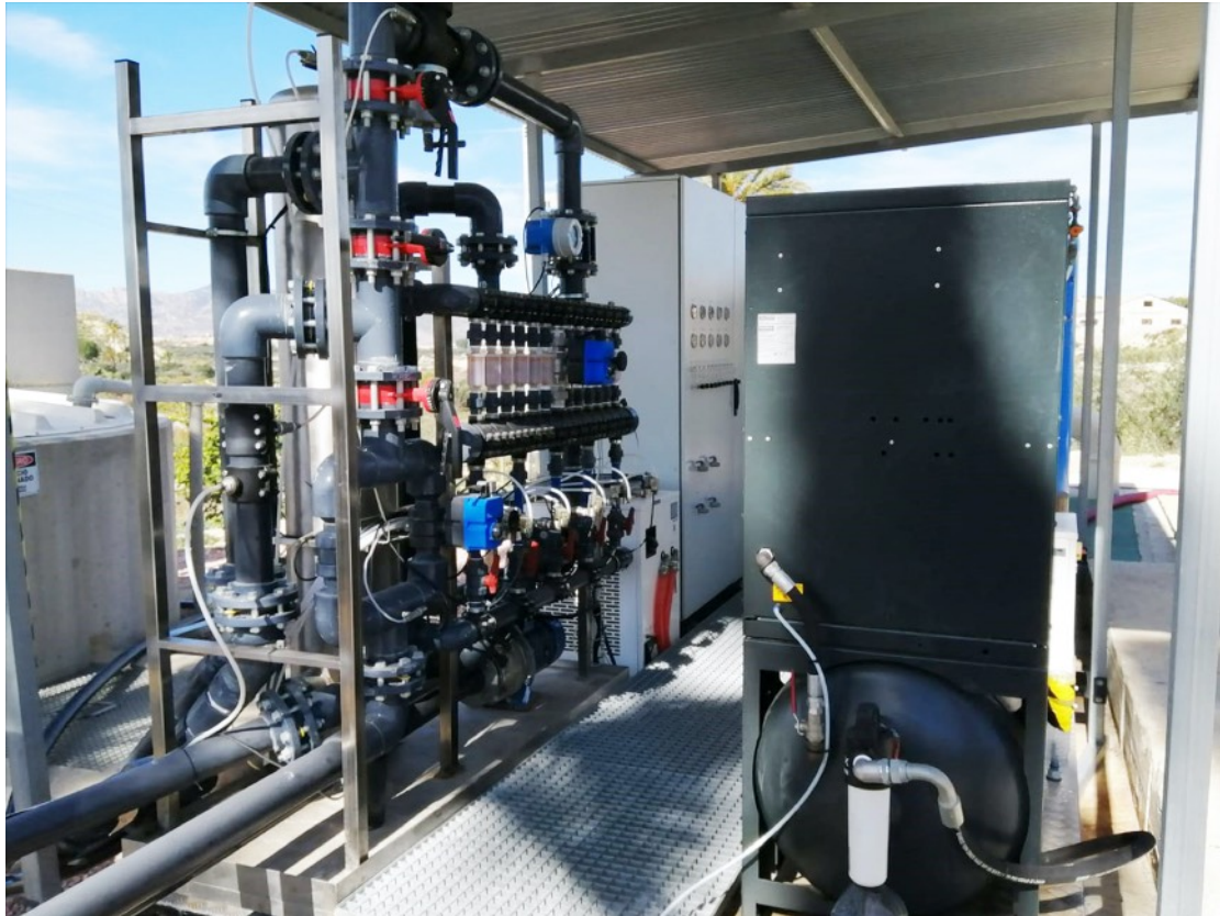
Foto-2: Detalle de elementos que conforman la planta de ozono
