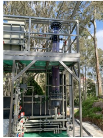
Imagen 4.- Detalle filtro de arena
