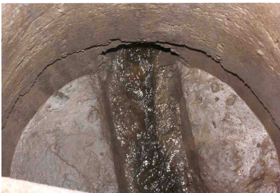
Foto 13. Salida del agua tras la segunda limpieza. Desagüe C/ Calzada
