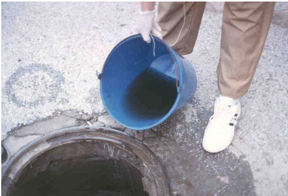
Foto 20. Salida del agua tras el enjuague del sector. Observa como tiene una gran cantidad de sólidos que se han arrastrado.
