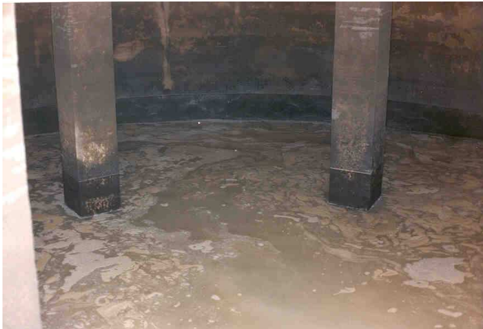
Foto 9. Estado del depósito una vez adicionado el H_2O_2 .
