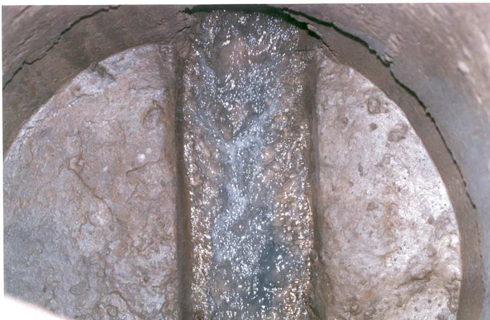
Foto 14. Salida del agua tras la tercera limpieza. Desagüe C/ Calzada
