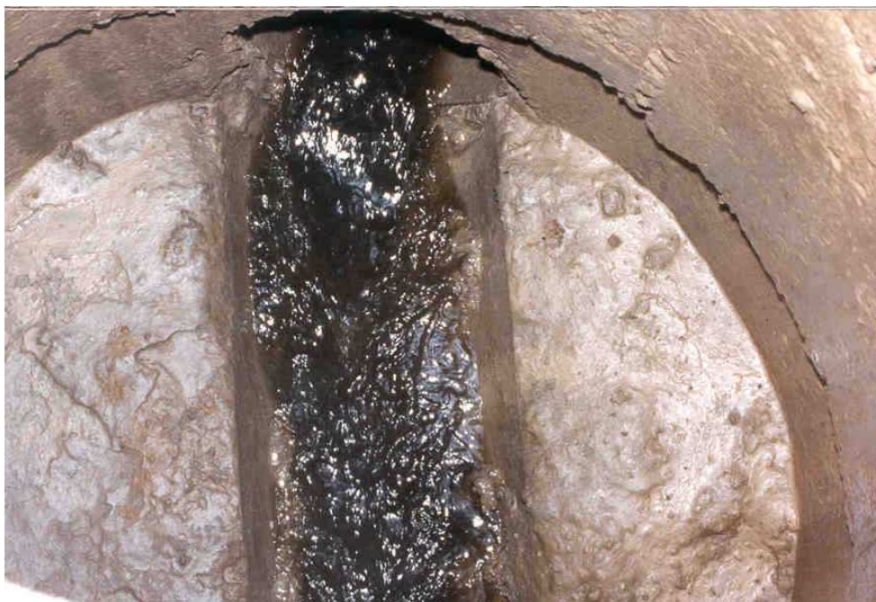
Foto 12. Salida del agua tras la primera limpieza. Desagüe C/ Calzada
