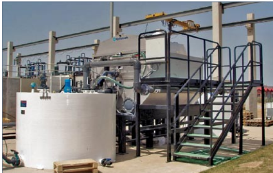
Figura 10: Proyecto de demostración con el Hydrotech Discfilter HSF 2204/1 en la planta de regeneración de agua de El Baix Llobregat.
