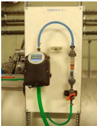
AquaScat 2 instalado en una industria cervecera para la monitorización del agua de entrada a proceso
