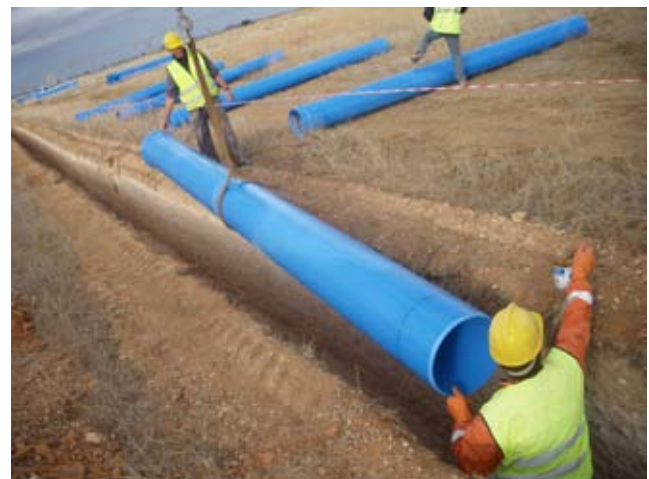
Instalación de tubería
