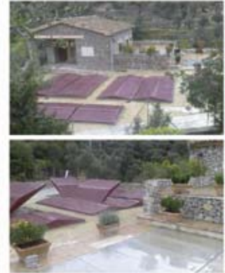
EDAR DEIÀ Deià - MALLORCA
