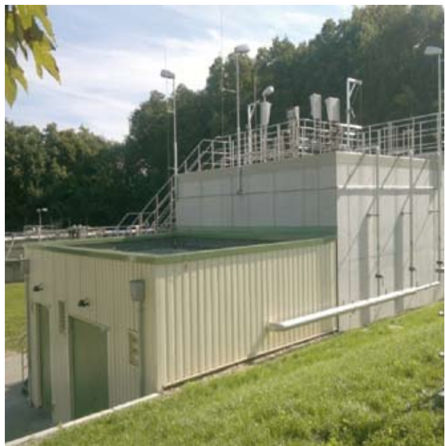
Figura 2. Aspecto de planta BIOMOX®-CFR en EDAR Potsdam Nord.
