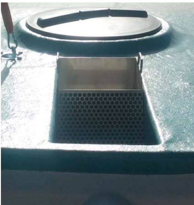
Reja de desbaste y cesta de sólidos
