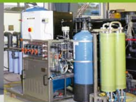
Tratamiento de Lixiviados
