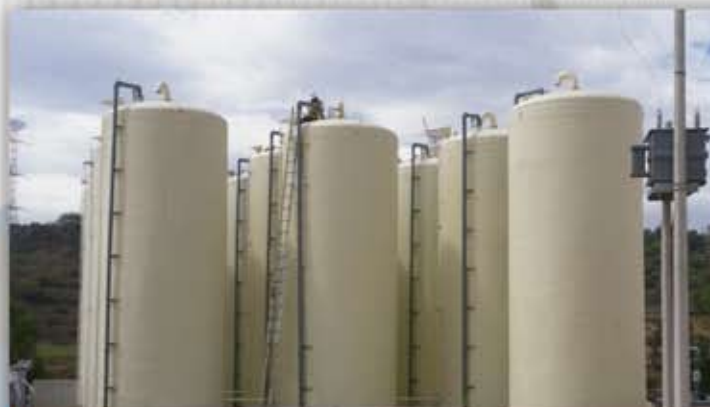
Tanques y Equipos en PRFV
