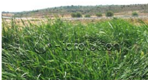
Balsa de tratamiento de fangos en la E.D.A.R. de Campillo del Altobuey (Cuenca): 600 m 2 de instalación.
