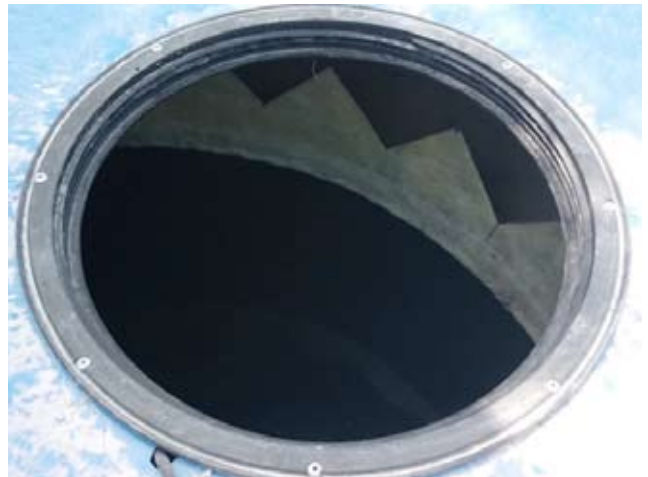
Clarificador con vertedero Thompson
