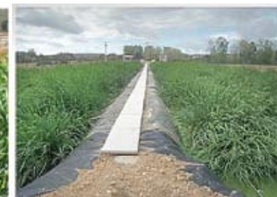
E.D.A.R. Hidrolution FMF® Integrada Tábara (Zamora): 1.950m 2 de instalación.
