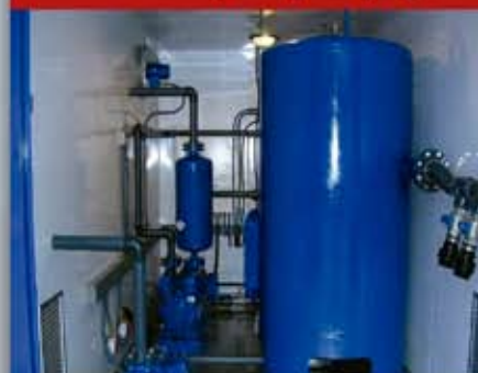
Tratamiento de Aguas
