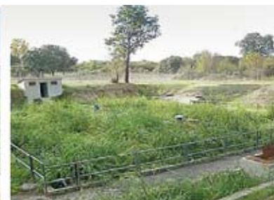
E.D.A.R. Hidrolution FMF® Combinada Ciudadcampo (Madrid): 245 m 2 de instalación.
