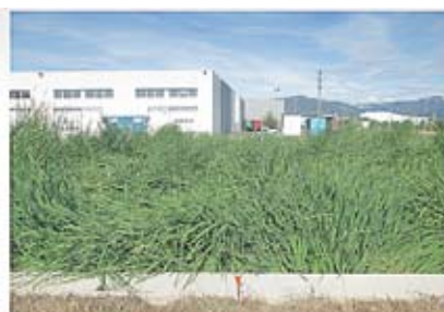
E.D.A.R. Hidrolution FMF® Integrada Polígono Industrial de Lantarón (Alava): 400 m 2 de instalación.
