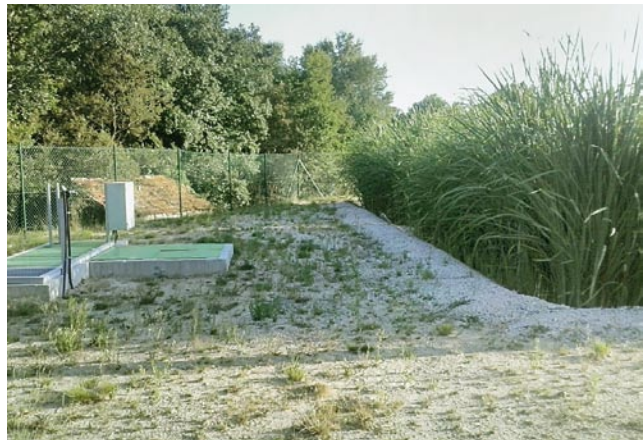
Detalle de la Estación Depuradora de Aguas Residuales Industriales y Urbanas de A Cañiza (Pontevedra) proyectada por el Técnico de ECOLAGUNAS S.L. D. Luis Felipe Fernández Fernández
