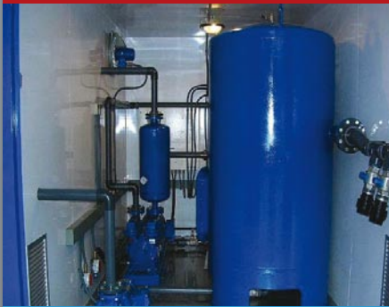
Tratamiento de Aguas
