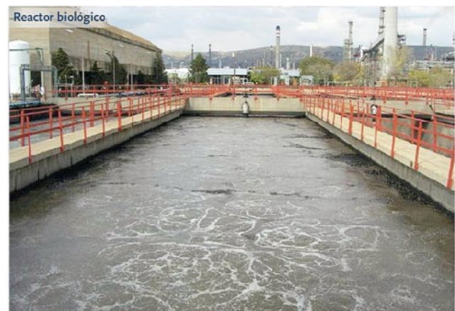
Uno de los canales del reactor biológico
