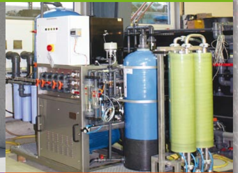
Tratamiento de Lixiviados
