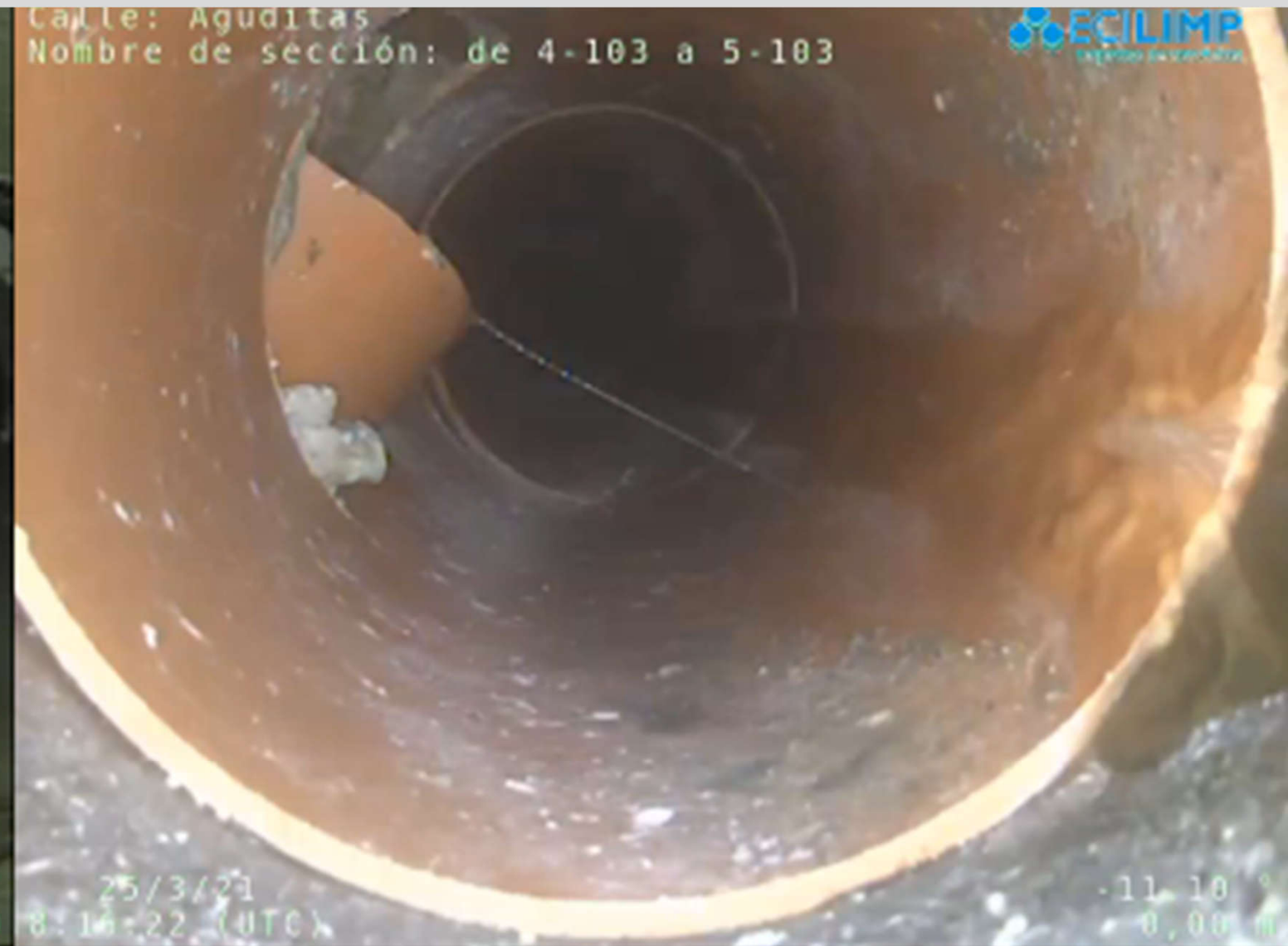
-TUBERÍA ANTES DE LA REHABILITACIÓN
