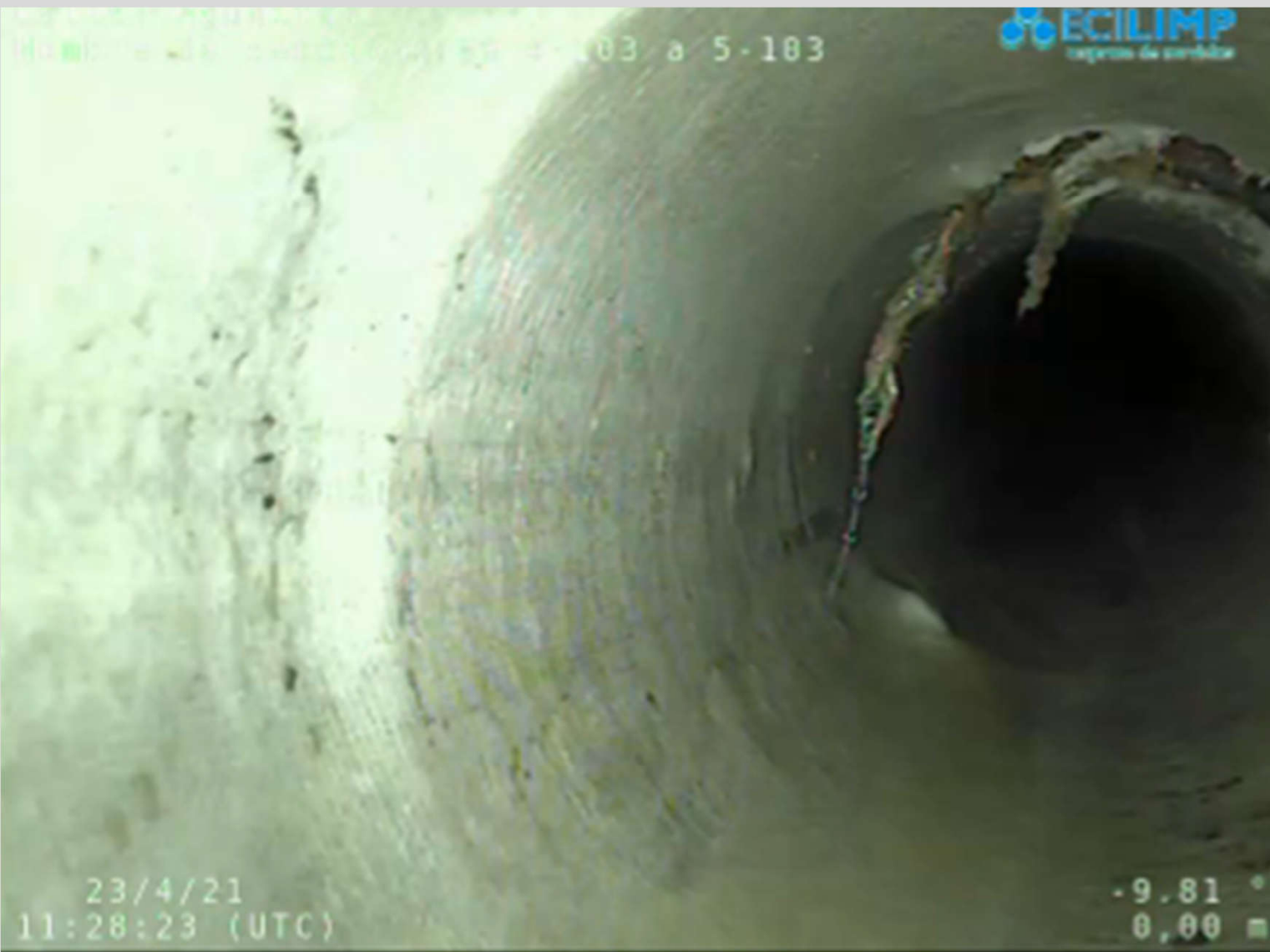
-TUBERÍA REHABILITADA CON MANGA
