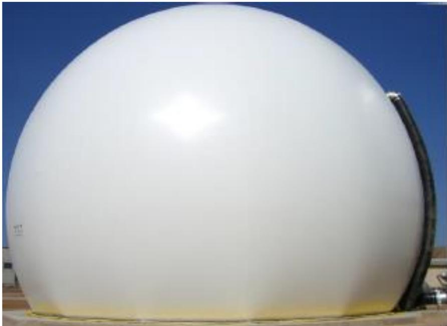
Gasómetro de doble membrana para almacenar biogás.
