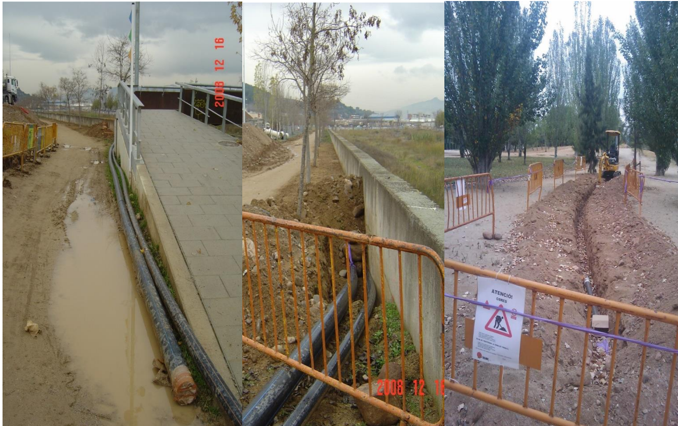
Tuberías de distribución
