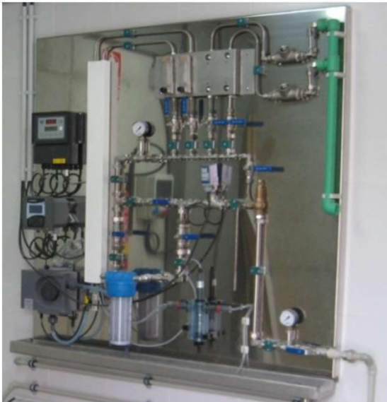
Panel de control (E.V.A.) de calidad en terciario Sistema Culebro.
