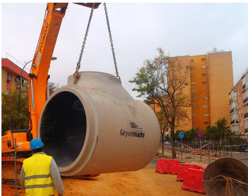
Pozo chimenea Tramo recto
