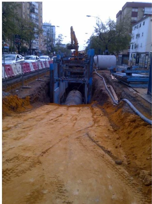
Nueva instalación de colector
