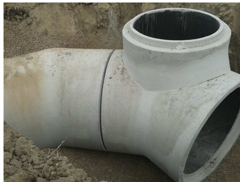
Pozo chimenea Tramo curvo + curva
