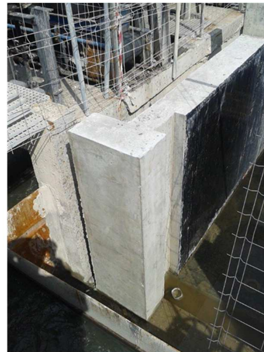
Ejecución de estructuras
