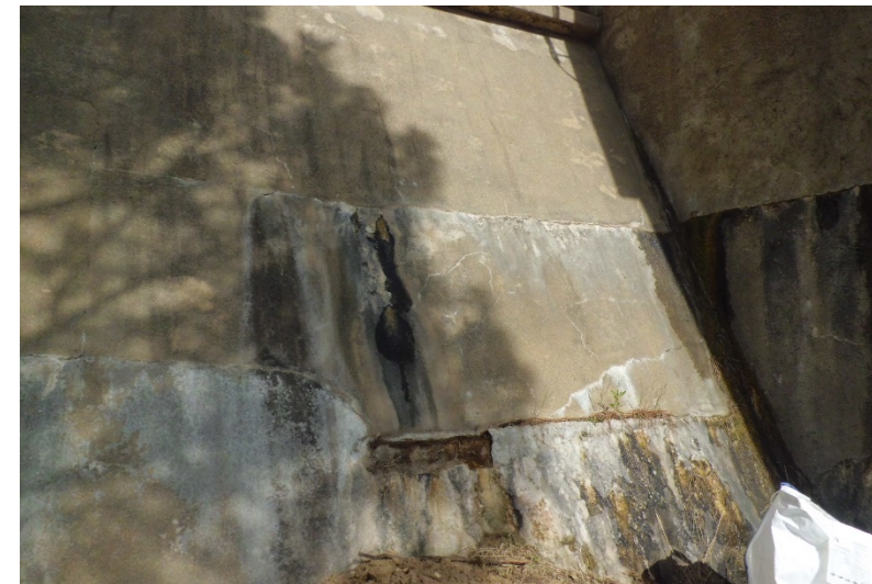
Ejemplo filtraciones existentes de dentro hacia afuera
