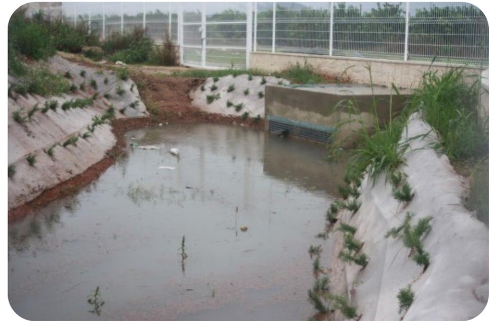
Cuneta vegetada con balsa final de detención e infiltración, en Xàtiva (Valencia).
