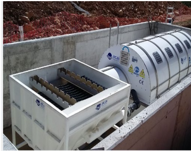
Contactores Biológicos Rotativos (CBR)
