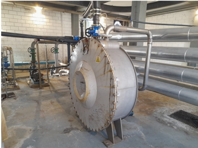
Intercambiador de espiral en serie.
