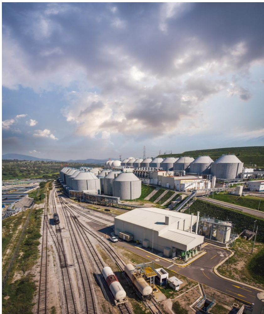
Exterior del Encapsulado de cloración y carrotanques de cloro
