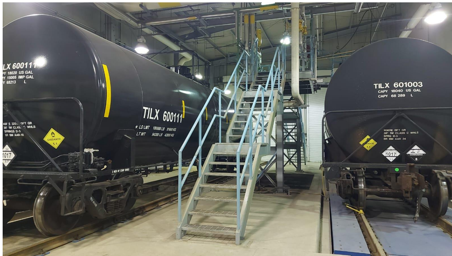
Interior del Encapsulado de cloración y carrotanques de cloro
