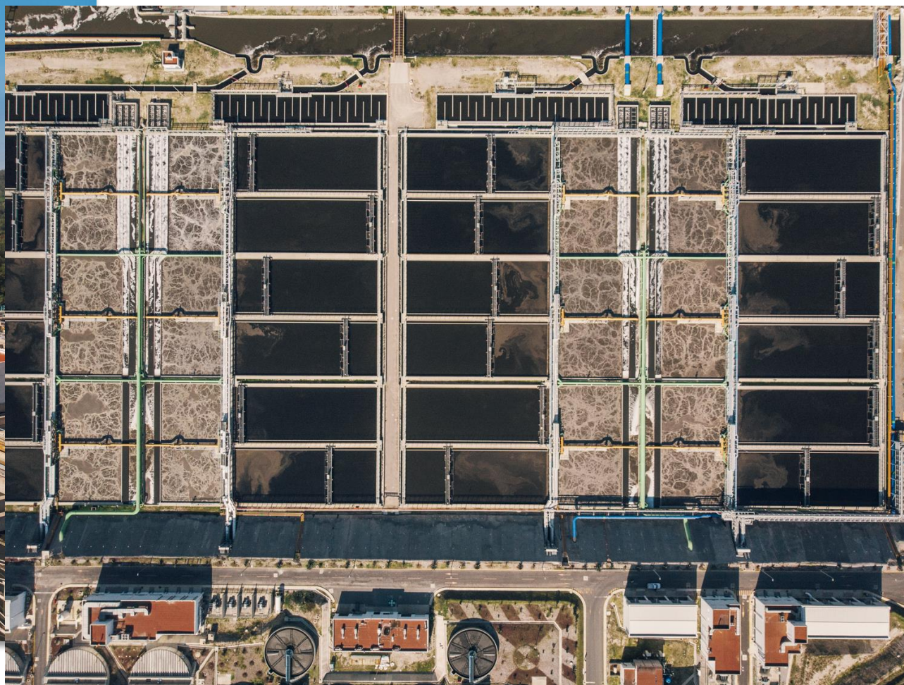
Reactores Biológicos y Clarificadores Secundarios
