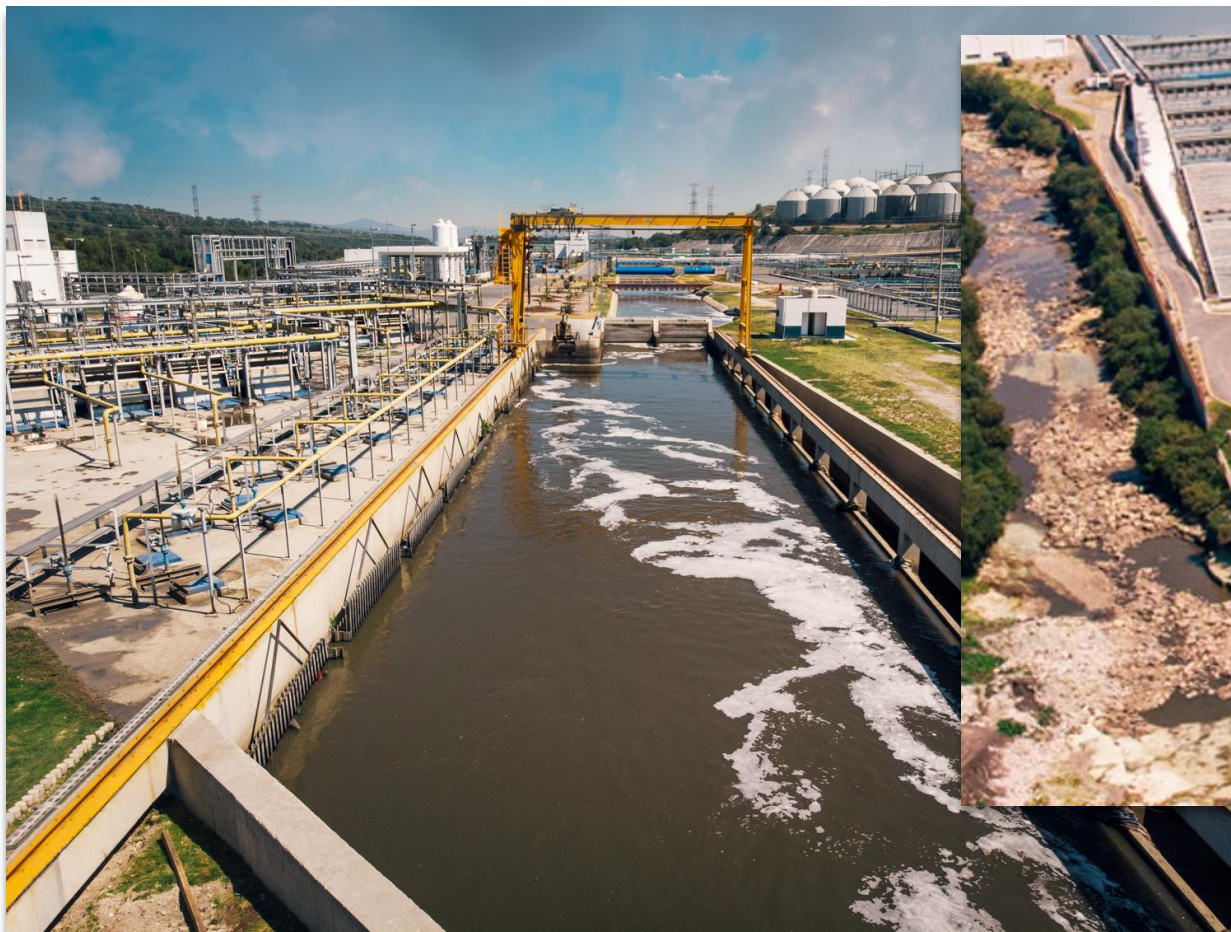
Canal de Entrada
