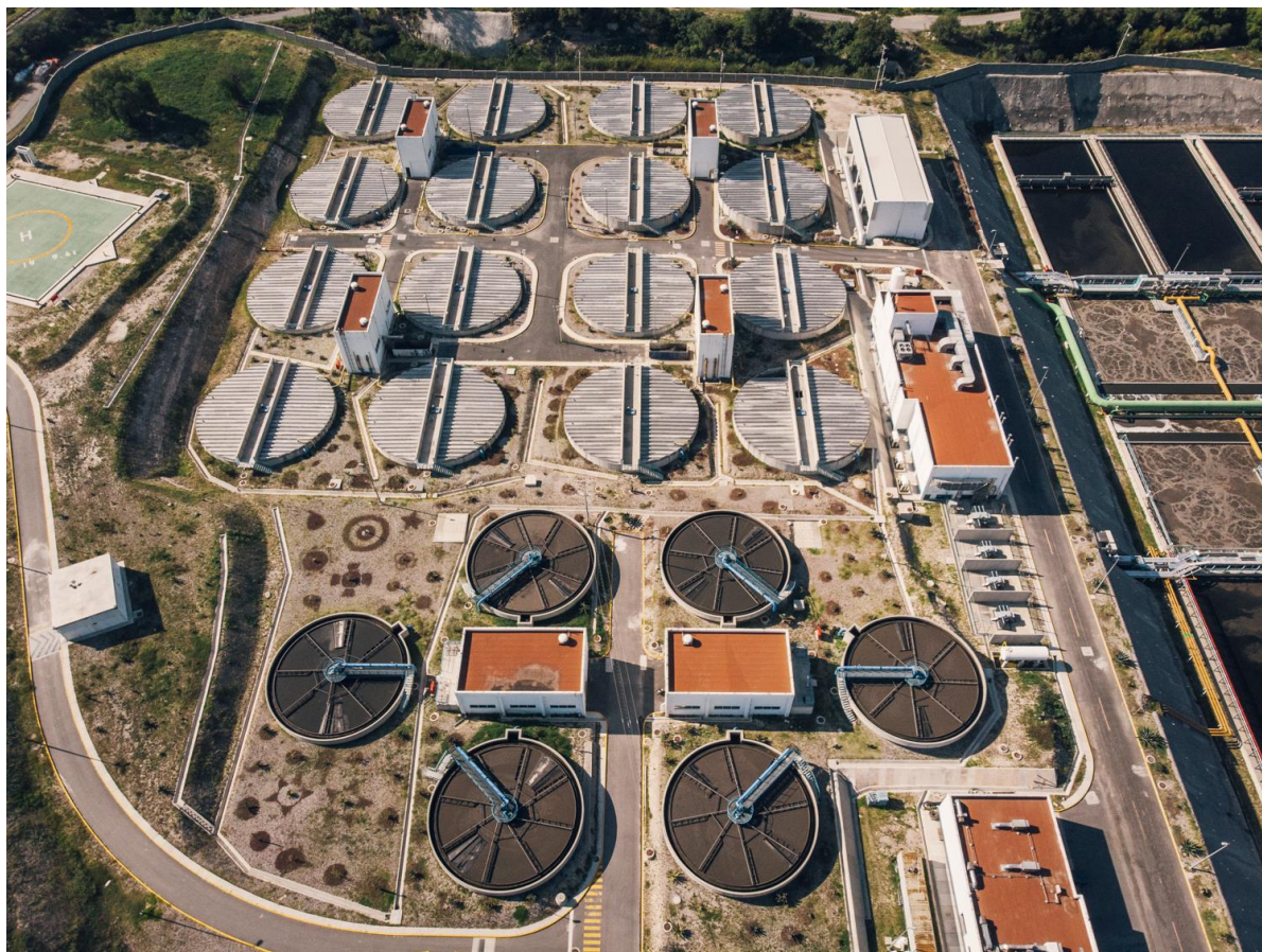
Espesadores de Gravedad y Flotación
