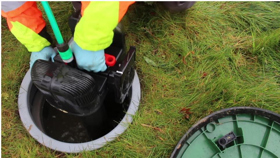
Limpieza de los componentes internos del equipo y un rascado superficial del biofiltro.
