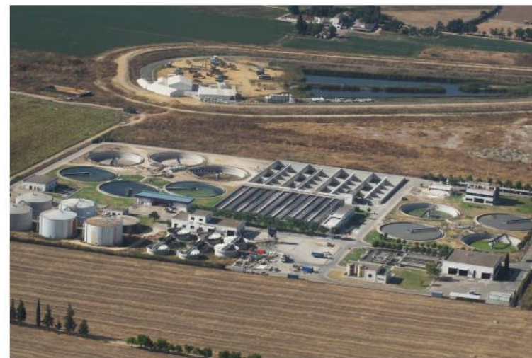
Instalaciones de la estación de depuración de aguas residuales de Palomares del Río (Sevilla). Pablo Puentes
