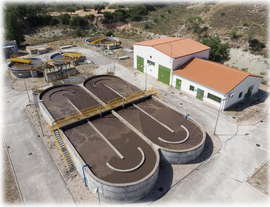
EDAR de Valdelaguna (3.750 h.e.)
