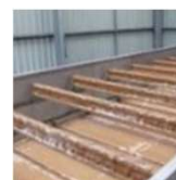
Deshidratación de lodos
