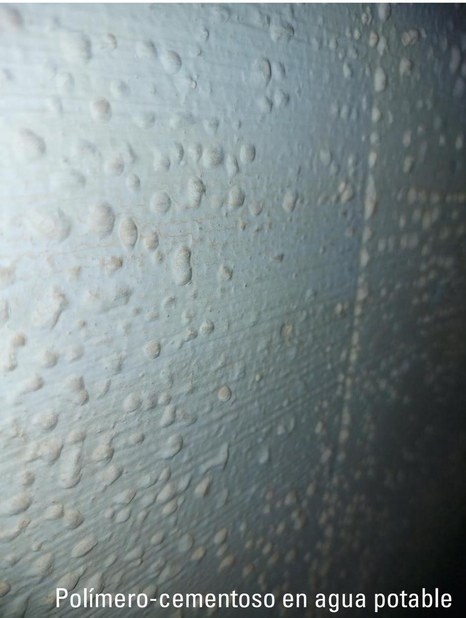
Polímero-cementoso en tanque de agua potable, fallo entre capas y en soporte.
