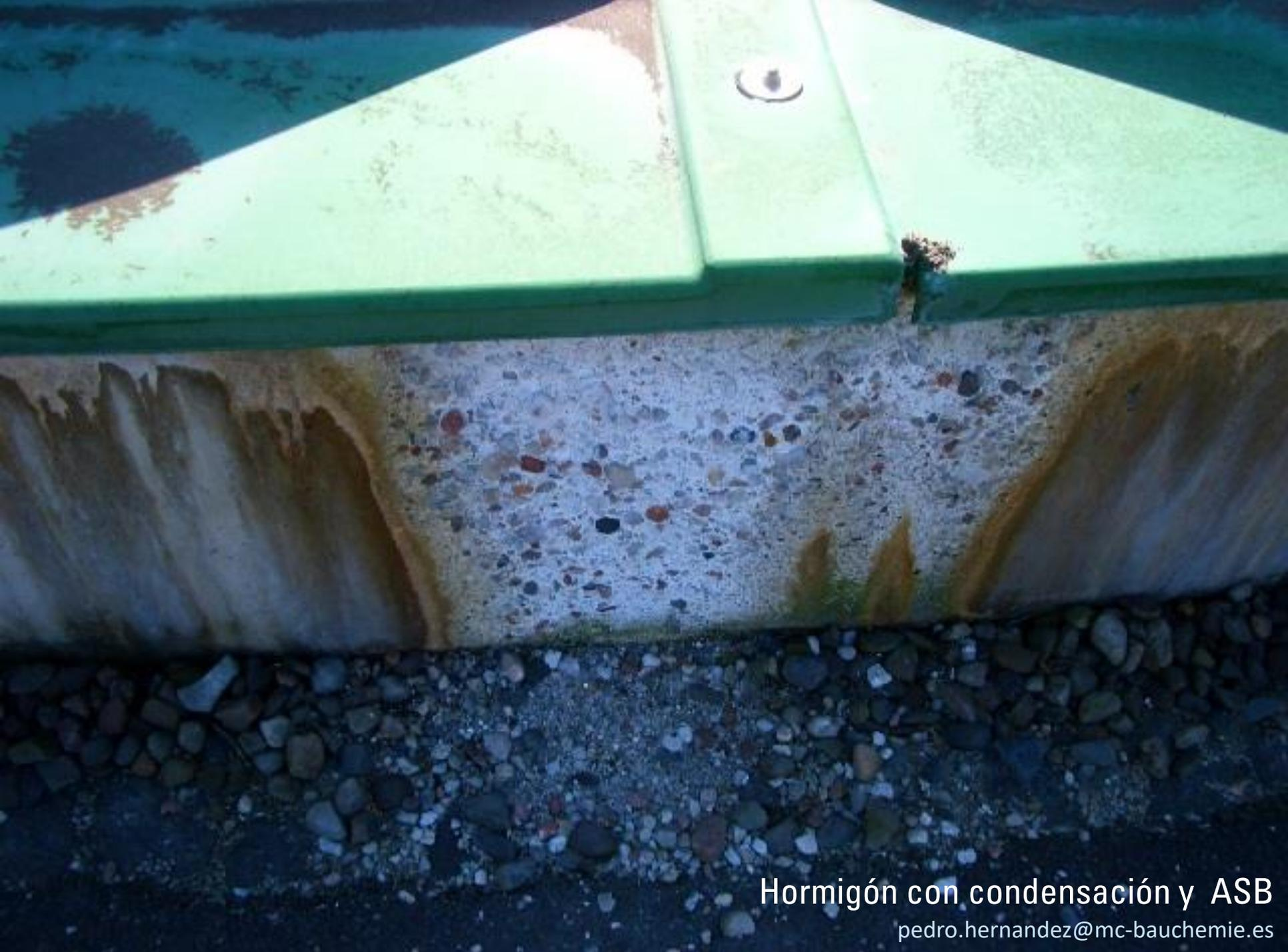
Hormigón con condensación y ASB
