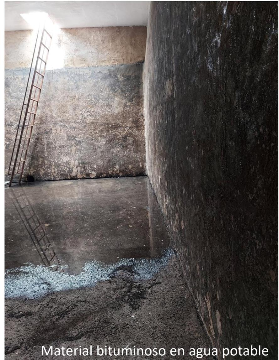
Material bituminoso en agua potable
