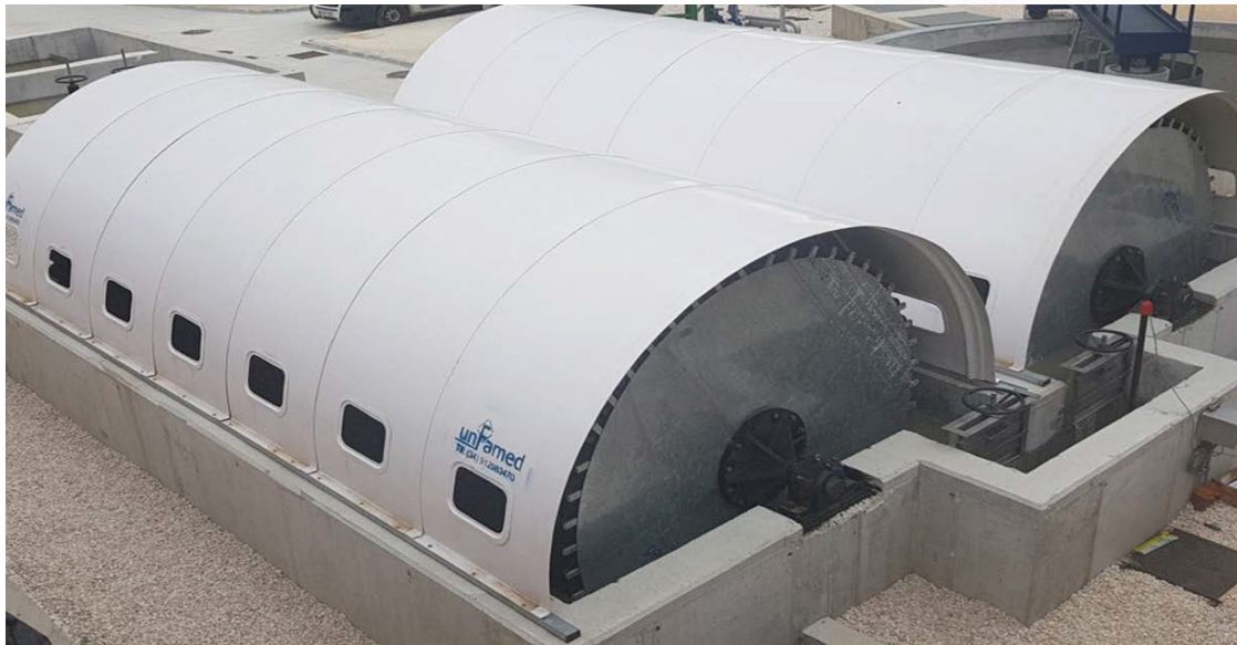
Biodiscos en la PTAR de Laguna de Negrillos, (León, España) (UNFAMED).
