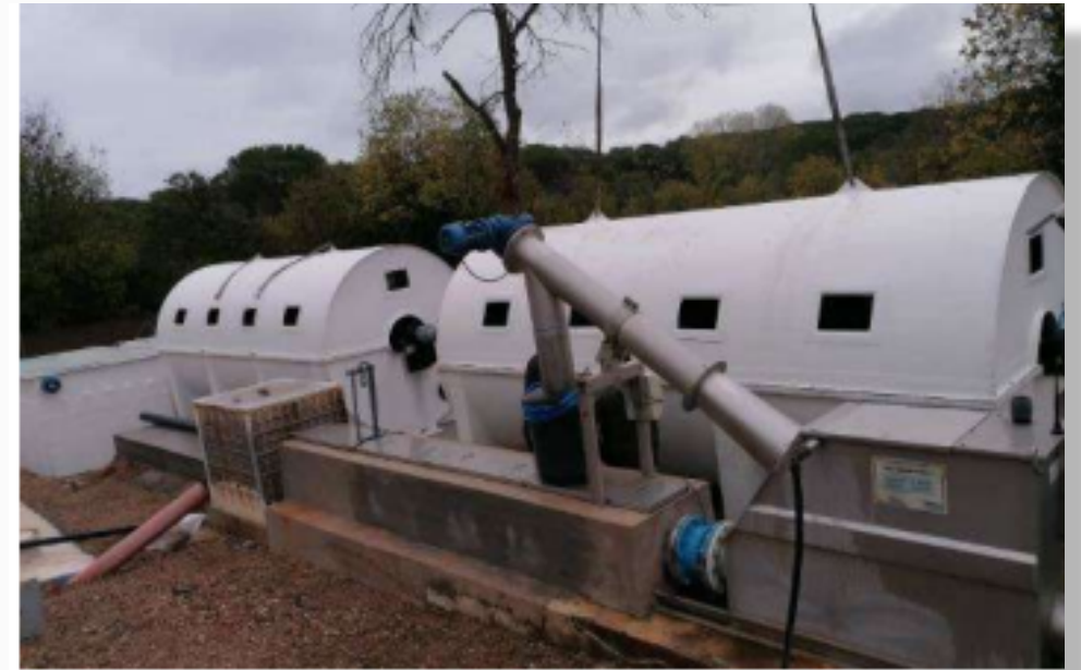
Biodiscos en la PTAR Trassierra 1, (Córdoba, España) (UNFAMED).
