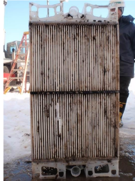
Antes de la limpieza
