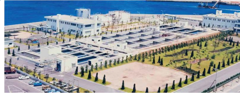
Diseño, Construcción, Operación & Mantenimiento de EDAR'S
