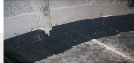
Reparación de un depósito de almacenamiento mediante parches internos de material compuesto.
