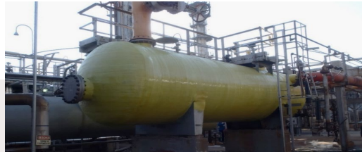
Refuerzo de un depósito de separación de antorcha (aplicación en alta mar), prolongación de la vida útil antes de la sustitución completa.
