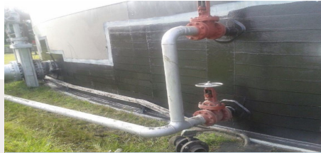
Reparación de un depósito de almacenamiento mediante parches externos de material compuesto.
