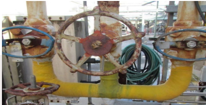
Reparación de tuberías de alta presión (aplicación en alta mar)
