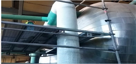
Reparación de un conducto de agua de refrigeración (corrosión externa)
