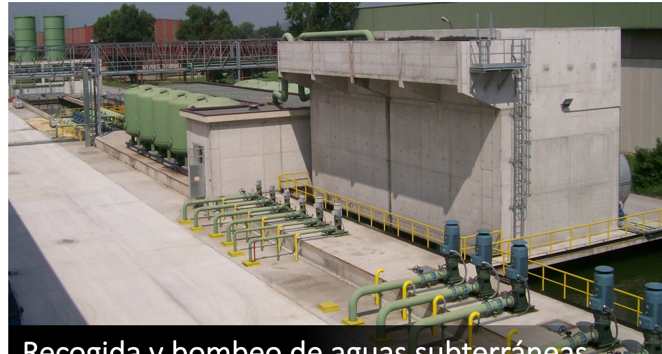
Recogida y bombeo de aguas subterráneas
