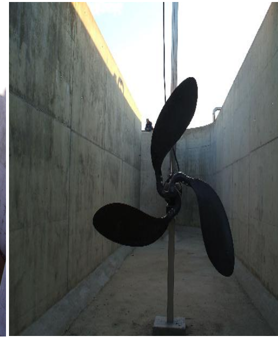
EDARS – Aireación y Agitación
