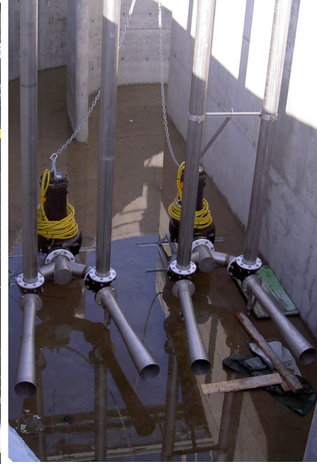
EDARS – Aireación y Agitación
