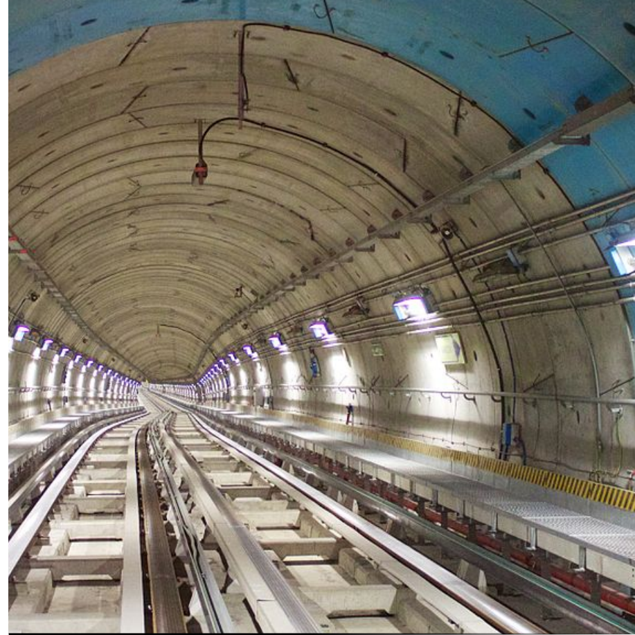
Recogida y bombeo de aguas subterráneas
