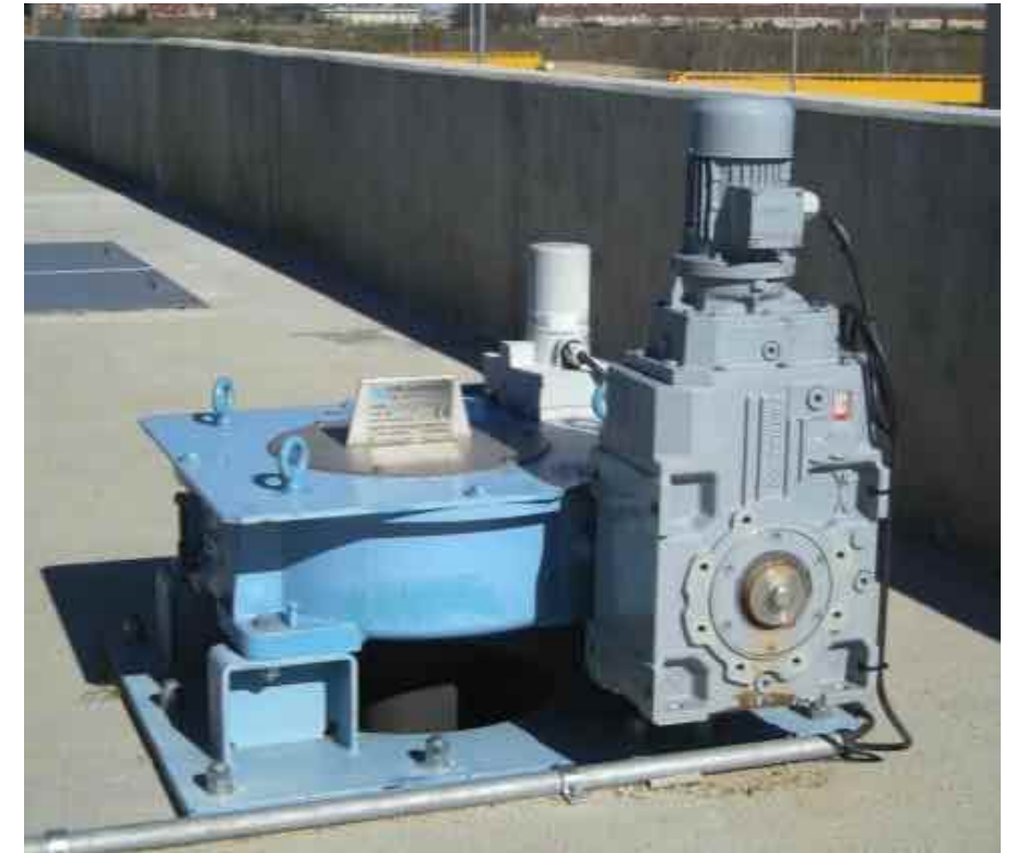
Cabezas de accionamiento central (espesamiento)
