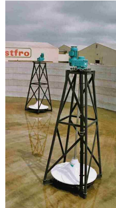
Agitador hiperboloide montado en torre extraíble
