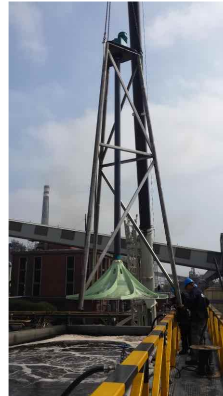
Agitador hiperboloide montado en torre extraíble
