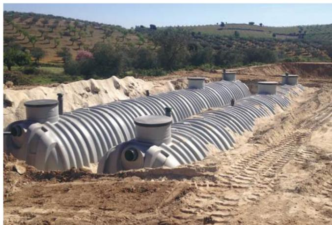
La aireación del sistema se realiza mediante la acción de un sistema de difusores de membrana, alimentado por un soplador de canal lateral, la descarga del efluente tratado se efectúa por gravedad y la recirculación de los lodos biológicos al reactor se realiza a través de una bomba sumergible ubicada en el decantador secundario.
