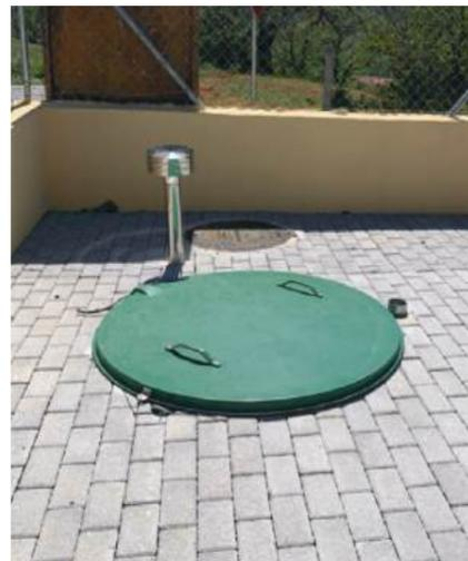
Las estaciones o pozos de bombeo se utilizan para regular el caudal de las aguas residuales del sistema y proporcionar presión extra cuando el movimiento natural por gravedad no es posible. Como por ejemplo al conectar las aguas residuales de un edificio a la red municipal o para bombear las aguas residuales de una EDAR a la zona de descarga.
