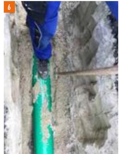
6 Una vez que se ha instalado una sección de tuberías, es fundamental rellenar con arena la parte inferior de las mismas, prestando especial atención a los riñones de la misma.
