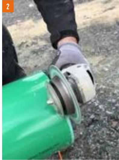
2 Las rebabas o zonas irregulares que se formen al acortar los tubos deben eliminarse con herramientas adecuadas. Además, se debe asegurar que el extremo cortado tenga un bisel nuevo y limpio. Para ello, se puede utilizar una lima o una herramienta flexible.
