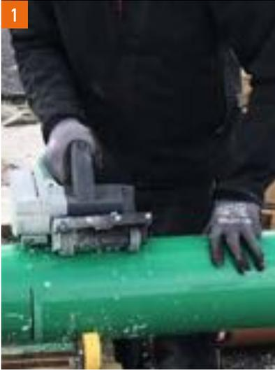
1 En caso necesario, nuestros tubos KG2000 se pueden cortar a la longitud requerida en la obra. Para ello, se puede utilizar una sierra, un cortatubos estándar o un sistema profesional de corte de tubos.
