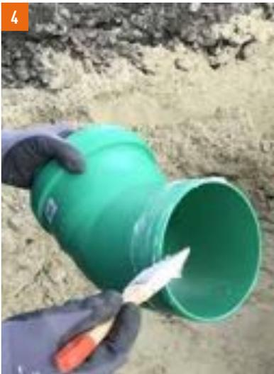
4 El extremo del cabo del tubo y la superficie interior de la copa deben estar limpios y libres de daños. Se debe aplicar un lubricante adecuado en todo el contorno del extremo del cabo.
