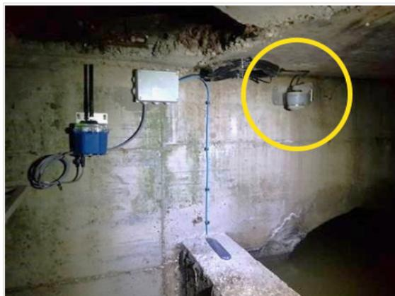
Monitorización de un aliviadero (muro) en el sistema de saneamiento: Sonda capacitiva para detectar el inicio y el final del vertido por el labio del aliviadero + Sensor de nivel + Registrador de datos (data-logger). Cortesía de **CleanWater**, **Microcom** y **VEGA**.
