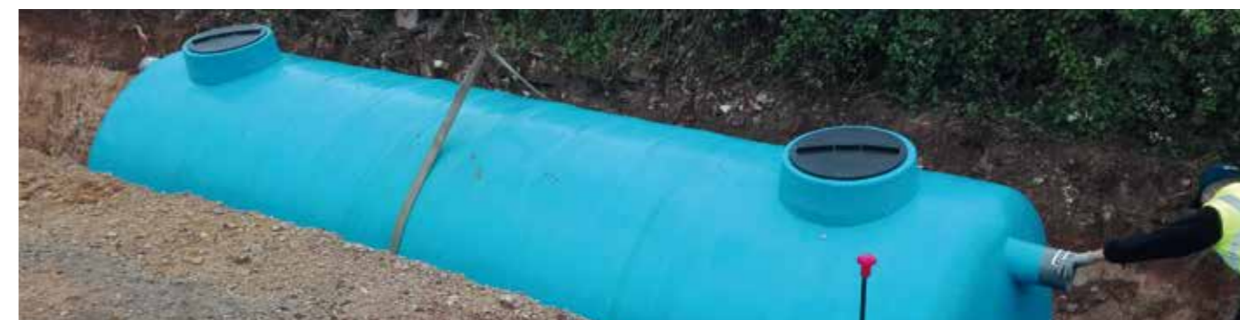
Instalación depósito DRP-F
