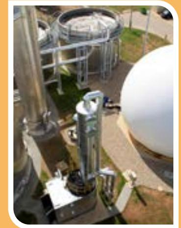
Antes de que se pueda utilizar el biogás, es esencial eliminar los compuestos de azufre, que están presentes principalmente en el biogás como sulfuro ( $H_2S$ ). El azufre puede causar corrosión en calderas y motores que utilizan biogás. Durante la producción de biogás, el azufre se convierte biológicamente a  $H_2S$ . También se pueden utilizar procesos biológicos para eliminar el  $H_2S$  del biogás.
