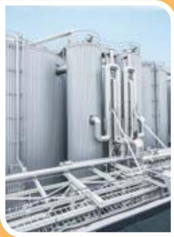
Los reactores de alta velocidad de Biothane son la tecnología líder para procesos anaerobios granulares de tratamiento de aguas residuales, que aprovechan el potencial de las aguas residuales para su valorización energética (biogás), recuperación de nutrientes y reutilización del agua.
