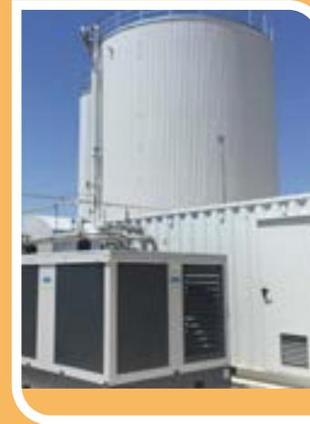
La conversión de biogás en biometano implica 3 pasos principales: pretratamiento, compresión y separación de metano. La separación de biogás por membranas es una tecnología contrastada para la producción de biometano, que se basa en la permeabilidad y selectividad de la membrana respecto a diferentes gases.
