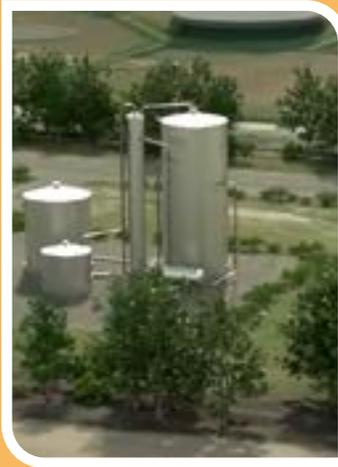
El innovador proceso separa el efluente anaeróbico de la biomasa fuera del reactor, lo que permite una mayor eficiencia y una mejor calidad del agua tratada. Es la solución perfecta para aguas residuales con alto potencial incrustante y de precipitación, ya que no es necesario vaciar ni abrir el reactor.
