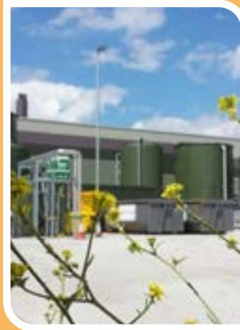
Biorreactor de membrana anaeróbica (AnMBR) que maximiza la producción de energía renovable mientras produce un efluente de alta calidad que puede ser reutilizado o vertido. Es una solución de tamaño reducido que ofrece una variedad de beneficios, reduciendo los costes de eliminación y produciendo biogás.
