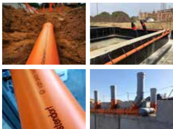
Instalación de tuberías en diferentes países de Europa.
