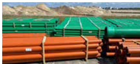
Renovación de la pista de aterrizaje de Aeródromo de la OTAN, Puerto de Wittmund (Alemania)
