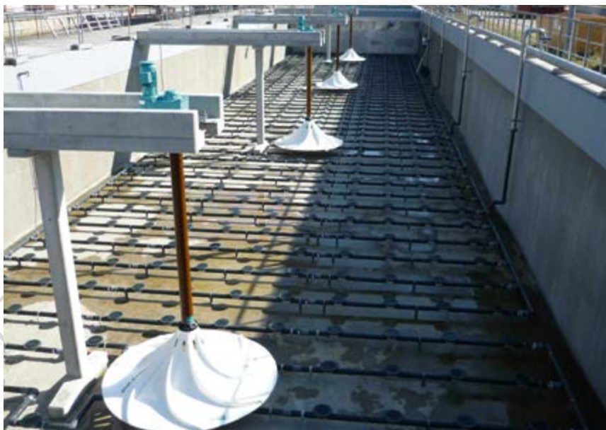
4 agitadores INVENT HYPERCLASSIC® combinado con sistema de aireación iDISC®
