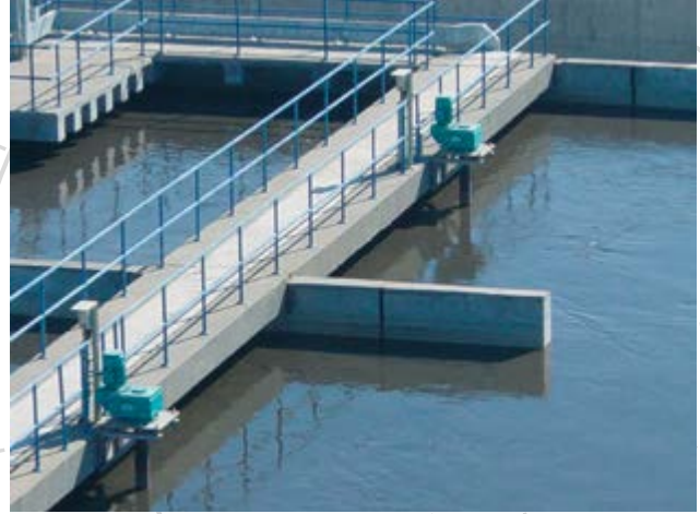
2 agitadores HYPERCLASSIC® de un total de 45 en una planta de tratamiento de aguas residuales en Kuwait City, Kuwait
