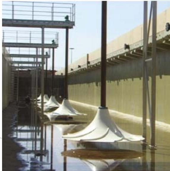
6 agitadores HYPERCLASSIC® de un total de 120 en una planta de depuración en Berlín, Alemania
