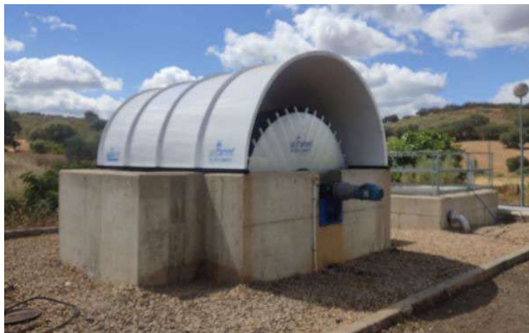
E.D.A.R NAVALPINO– rehabilitación (Ciudad Real)
