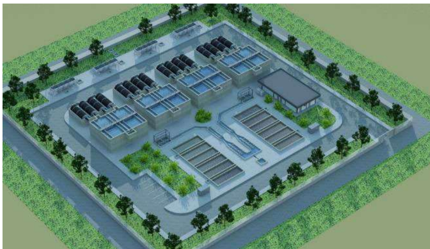
PLANTA DE BIODISCOS UNFAMED (E.D.A.R. Cárdenas, Cuba)
