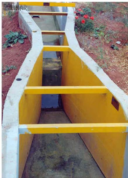
La Tabla 6.9 recoge, para distintos anchos de garganta, los niveles de caudales máximo y mínimos que pueden medirse haciendo uso de canales Parshall (De Acevedo y Acosta, 1976).
