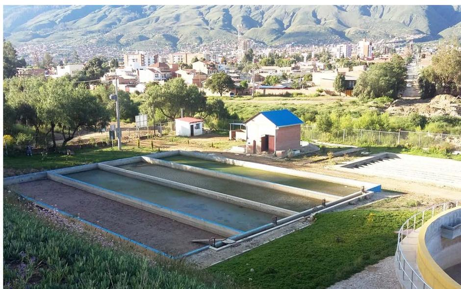
La aplicación de Humedales Artificiales para el tratamiento de lodos es una opción relativamente reciente, que permite la estabilización/secado de estos subproductos, obteniéndose un compost (mezcla de lodos estabilizados y de la vegetación del humedal que se corta periódicamente).
