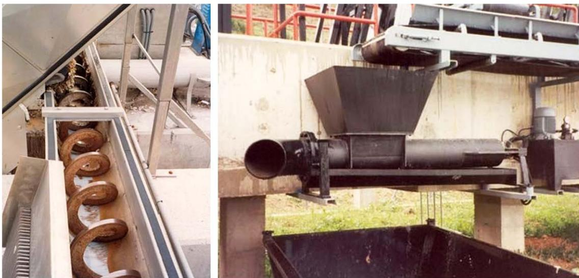
En las PTAR de mayor tamaño los residuos retirados en la etapa de desbaste se prensan antes de depositarlos en los contenedores. Con ello se logra una importante reducción en el volumen de los residuos generados (abaratando su transporte), a la vez que se minimiza la aparición de malos olores, al frenarse los procesos de putrefacción, como consecuencia de la disminución de su contenido en humedad.
