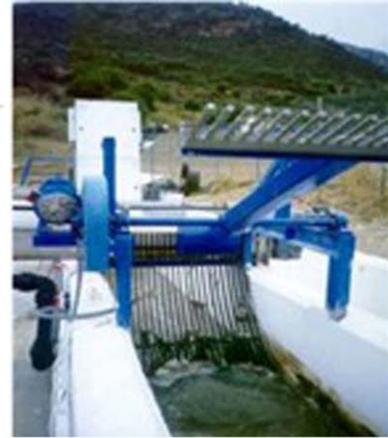
Este tipo de rejas son apropiadas para su instalación en canales poco profundos (0,4-2,0 m). La altura del agua alcanza, normalmente, el 75% de la longitud del radio y la evacuación de los residuos se realiza a poca altura, por encima de la lámina de agua.
