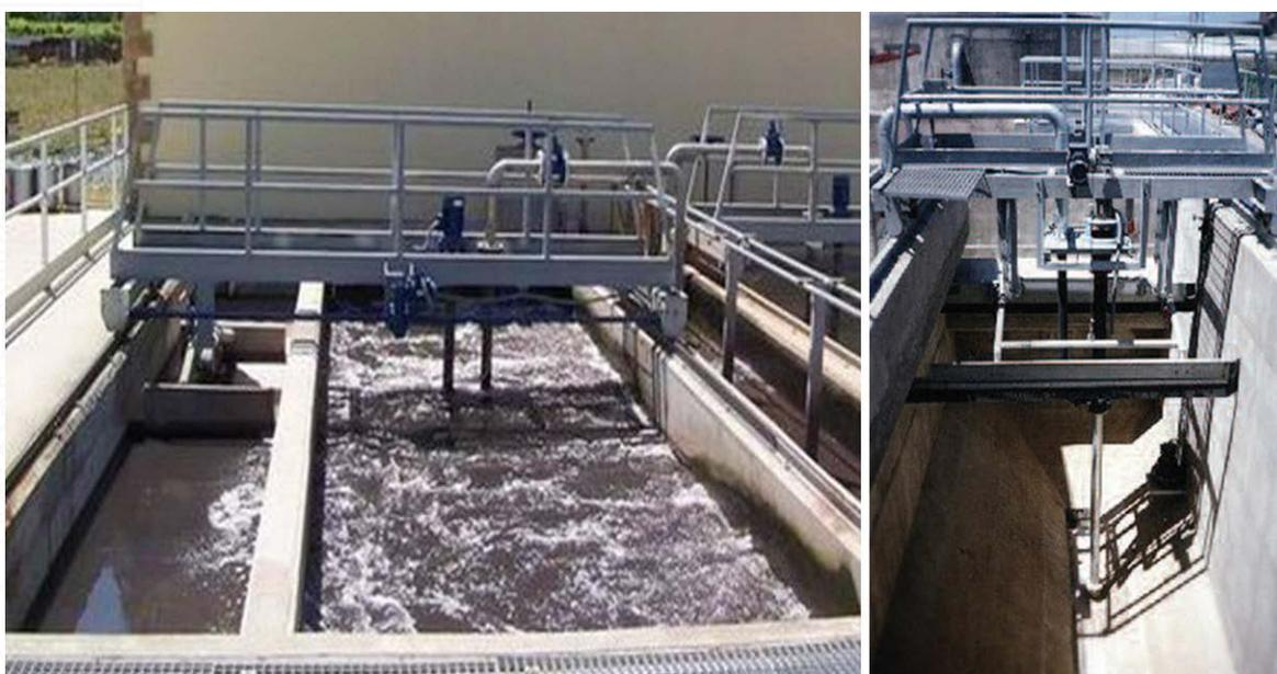
Las mezclas agua/grasas (extraída por las rasquetas) y agua/arenas (extraída por la bomba de arenas), se conducen a un concentrador de grasas y a un clasificador de arenas, respectivamente, de los que se extraen ambos residuos, mientras que las aguas se retornan a la obra de llegada de la PTAR.
