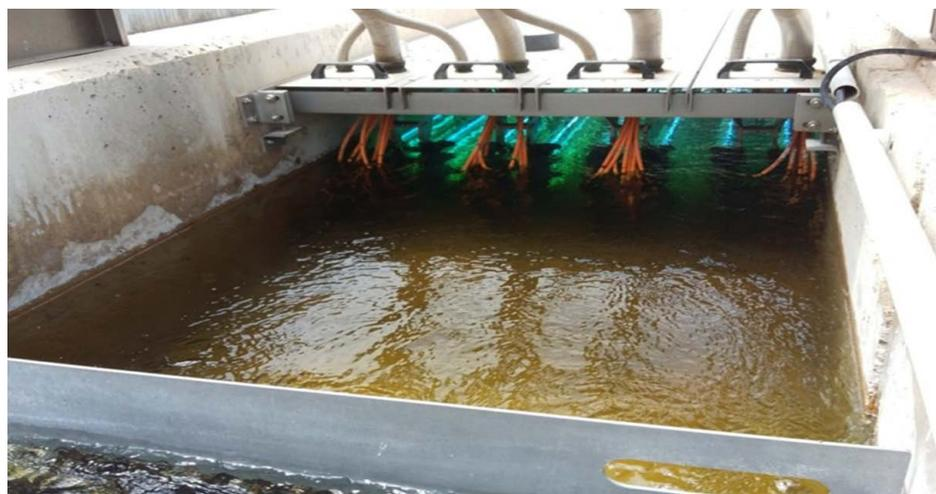
Frente a la Cloración, la Radiación UV presenta la ventaja de no generar subproductos tóxicos para la salud y el medioambiente. Como principal inconveniente cabe destacar que, en ocasiones, los patógenos pueden reparar los daños ocasionados por la radiación UV (fotorreactivación) (Salcedo et al., 2007), por lo que hace necesario completarla, generalmente mediante cloración a dosis bajas.
