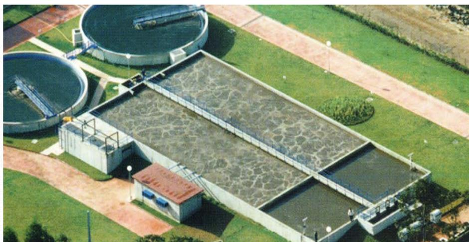
Como principales ventajas de esta tecnología caben destacar: el reducido requisito de superficie para su construcción, el hecho de que los lodos en exceso se encuentran estabilizados y su versatilidad para la eliminación de nitrógeno. A resaltar entre sus desventajas la complejidad de su operación y elevados costos de operación y mantenimiento.
