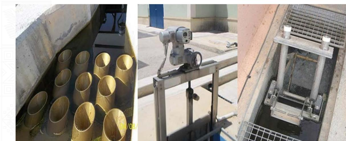
En el caso de los reactores cerrados, normalmente el caudal que pasa por ellos se bombea previamente, por lo que el caudal se regula en los equipos de bombeo, mediante variador y caudalímetro. En el caso de funcionamiento por gravedad, la regulación se lleva a cabo mediante válvula automática y caudalímetro.
